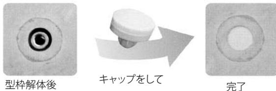
⚠️ 左官補修(タイル下地・ペンキ下地等)を行う場合は、キャップを使用せずそのまま補修してください。
